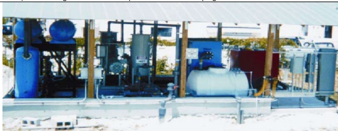
b) Technológia bioslurpingu v plnej prevádzke
